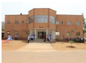
Nouveau bâtiment (Ecole Nationale de Police)
