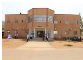
Nouveau bâtiment (Ecole Nationale de Police)
