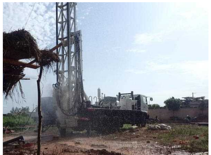
Grandes foreuses en opération
