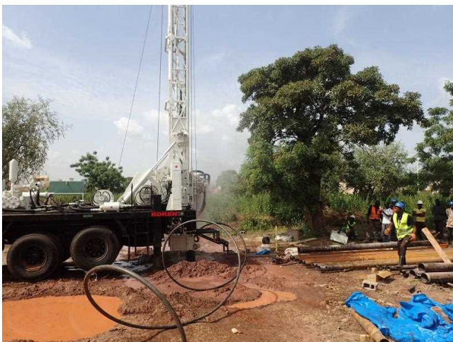
Grandes foreuses en opération
