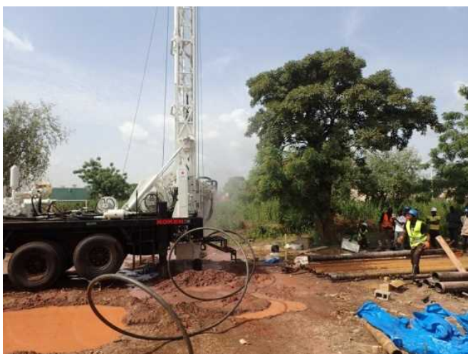
井戸掘削中の機材
