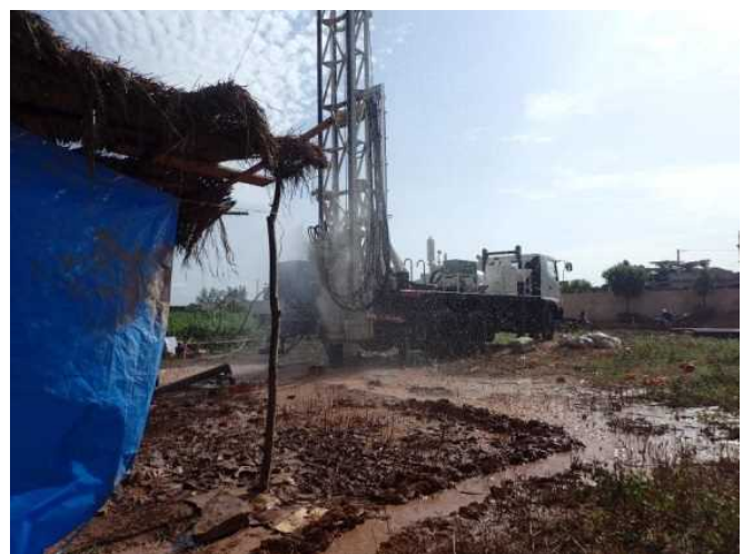
井戸掘削中の機材
