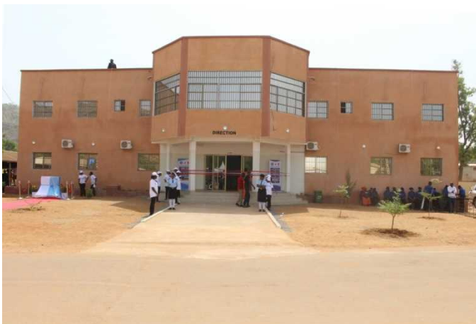
日本の支援で建設された警察学校管理棟
